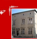
Au n° 6 de la rue de la Poterne se trouve un linteau de porte en plein cintre datant de l'année 1593.
